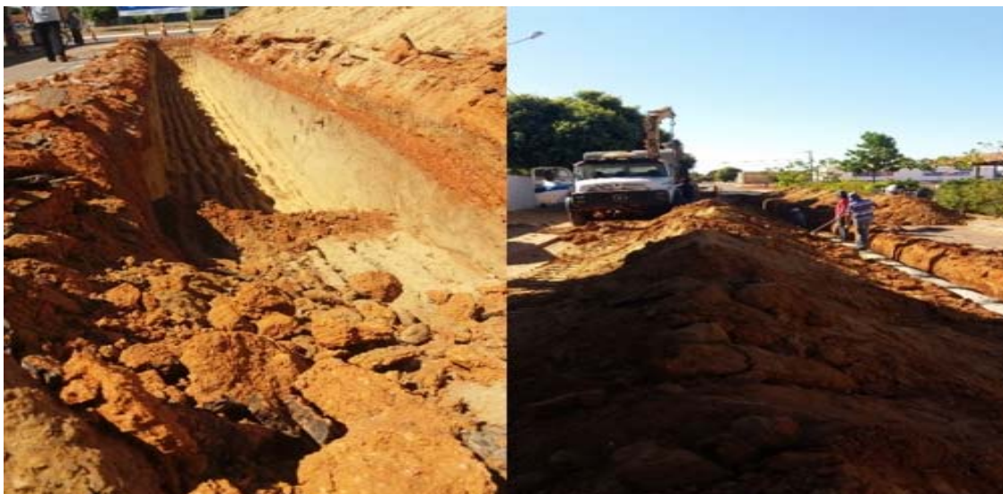
Figura 7A– Obras de drenagem de águas pluviais. Figura 7B– Obras de drenagem de águas pluviais. Fonte: Pesquisa direta. Fonte: Pesquisa direta.
