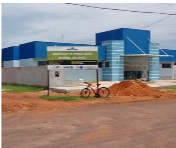
Figura 8A– UBS em fase final de execução.
